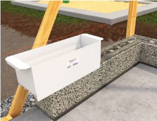
Applicera murbruk med murlåda eller med murslev. Säkerställ att fogarna är välfyllda och att de täcker bistålen.
