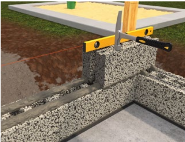
Mura med minst 1/4 blocks förskjutning. Säkerställ med jämna mellanrum att blocken ligger i våg och att de följer murarsnöret.
