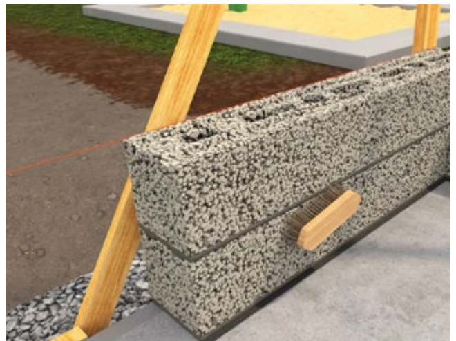
Skrapa bort överflödigt bruk med en murslev. Torrt bruk som ännu ej härdat borstas av med rotborste. Borsta diagonalt så att bruket ej dras ut fogarna.
